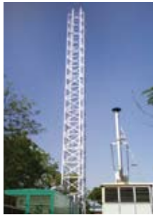
HUL – Kandla – 1 x 1010 kVA and 1 x 500 kVA
